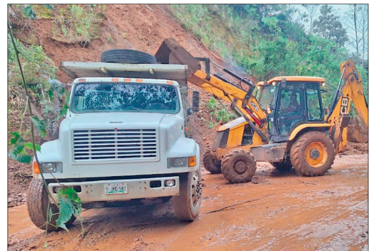
▶ Trabajadores de la residencia regional de Huejutla realizaron con una retroexcavadora el desazolve de cunetas y retiro de caídos en la carretera estatal Jaltocán-Coahuilco. Foto Cortesía
