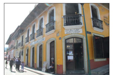
▲ El alcalde convoca a prestadores de servicios y comerciantes a pintar y dar mantenimiento a las fachadas de sus establecimientos. Foto Especial
