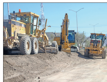
▲ La encargada de llevar a cabo los trabajos será la empresa Aufe Materiales para Construcción. Foto Benjamín H. V.
