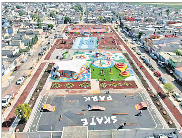
▲ La alcaldesa Azucena Cisneros recorrió el lugar donde se construyeron canchas deportivas y espacios de recreación.
