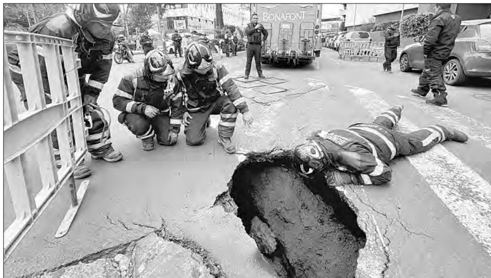
▲ Un pesado camión repartidor de agua purificada quedó atrapado en un socavón que se formó en el cruce de calzada Del Hueso y calzada de Los Tenorios, en la alcaldía
