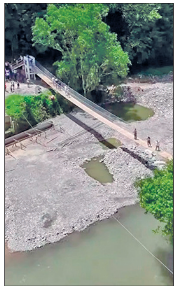
▲ Los habitantes ya pueden hacer uso del paso para transitar con seguridad. Foto Especial
