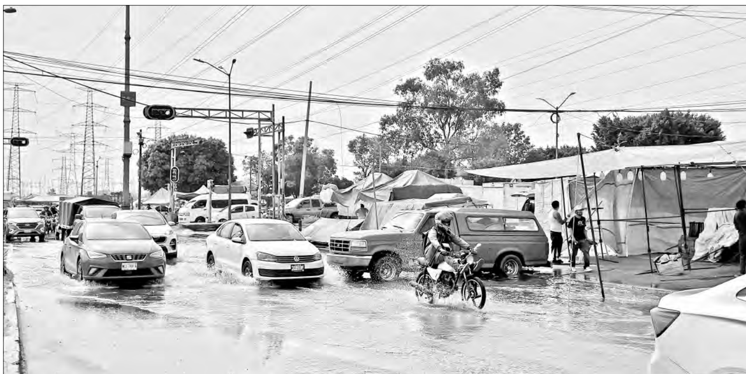
▲ En Iztapalapa, los trabajos de reparación de una megafuga de agua potable en una línea de 20 pulgadas de diámetro ocasionaron rezago vehicular sobre el Eje 6 Sur avenida de Las Torres, a un costado del parque Cuicláhuac, en la colonia Renovación. Foto Alfredo Domínguez
