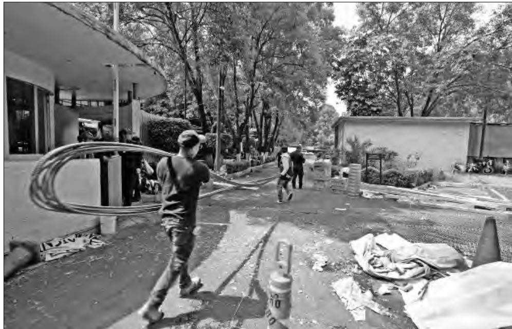
▲ Trabajadores del Canal Once realizaron ayer tareas de limpieza. Foto Alfredo Domínguez
