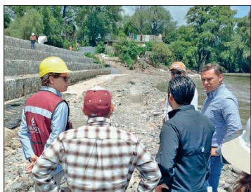
▲ Durante un recorrido por la zona, cerca de El Chamizal, se constató el avance en la colocación de taludes mediante estructuras de piedras y mallas. Foto Joselyn Sánchez
