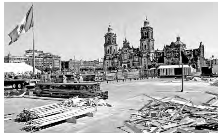
▲ El Mundial terminó y las estructuras del Fan Fest del Zócalo, donde miles de capitalinos disfrutaron de la transmisión de los 104 partidos, comienzan a ser retiradas por trabajadores del gobierno. Foto María Luisa Severiano
