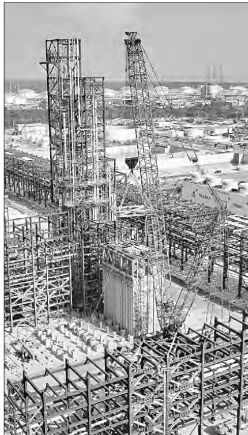
▲ La construcción de la refinерía Dos Bocas, en Tabasco, en 2022. Foto Presidencia
