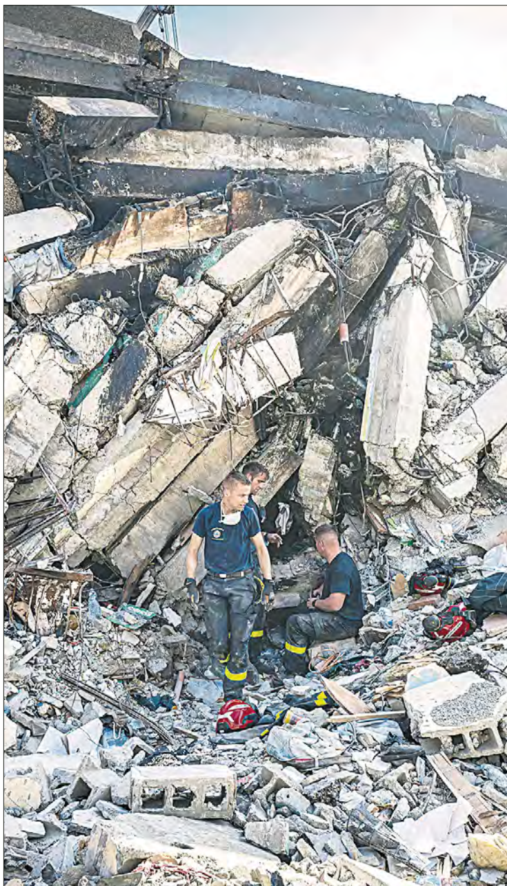
▲ Rescatistas franceses realizan trabajos en un edificio dañado en Catia La Mar, estado de La Guaira. Las esperanzas de encontrar sobrevivientes se desvanecen con el paso de las horas. Foto Afp
