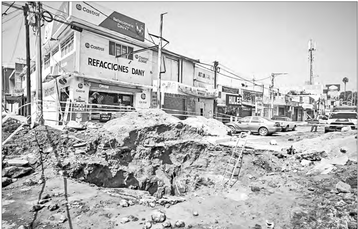
▲ Tras concluir la reparación de la tubería, un amplio boquete quedó expuesto entre montículos de tierra y restos de pavimento en
