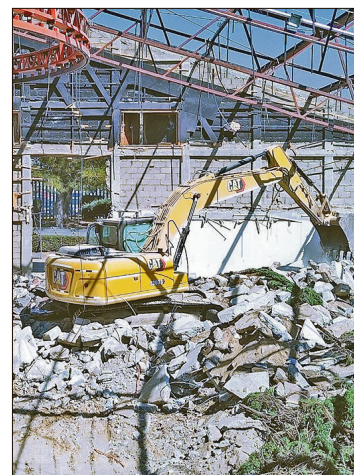
El desarrollo de la infraestructura contempla un plazo de ejecución de 366 días naturales. Foto Benjamín H. V.
