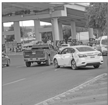
▲ Las obras se llevarán a cabo desde la Glorieta 24 Horas hasta el monumento al Bombero. Foto Benjamín H. V.
