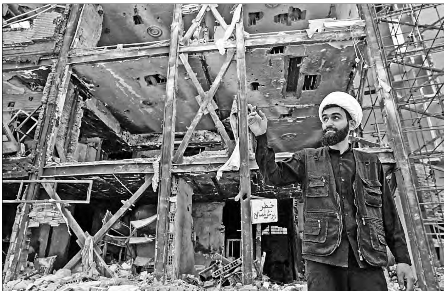
► Un clérigo iraní muestra los daños a un edificio residencial en el sur de Teherán alcanzado por ataques aéreos estadounidenses e israelíes días antes de que entrara en vigor el alto el fuego. Foto Afp
