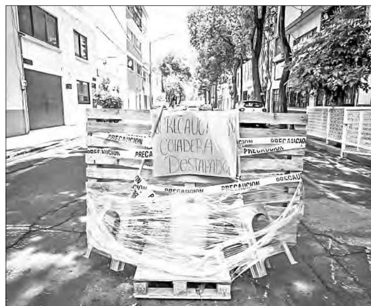
▲ Hundimientos, baches y deterioro en las coladeras evidencian el abandono de las autoridades en una vía usada como ruta alterna mientras las reparaciones deben salir del bolsillo de los afectados. Foto Mara Ximena Pérez
