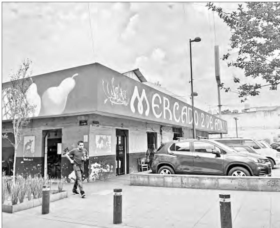
▲ A espaldas del teatro Blanquita, en la colonia Guerrero, se encuentra ubicado el mercado 2 de Abril, el cual ayer cumplió 124 años de su fundación y resiste el deterioro del tiempo y la extorsión de delincuentes a los locatarios. Foto Elba Mónica Bravo
