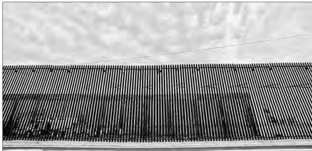
▲ Estados Unidos empezó la construcción de un segundo muro fronterizo en la zona
