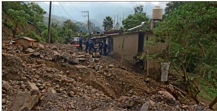
Afectaciones por lluvias
