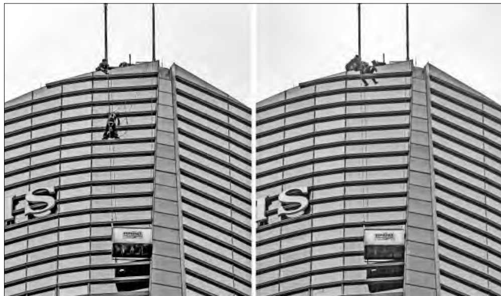
▲ Un trabajador quedó atrapado en un andamio mientras realizaba la limpieza de vidrios en el piso 31 del hotel St. Regis México, ubicado sobre Paseo de la Reforma.
