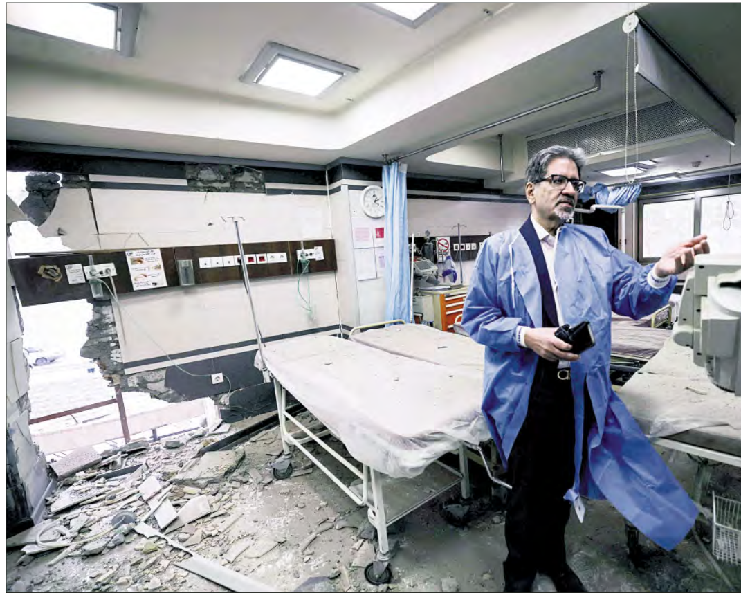
▲ Un médico muestra los daños en el hospital Gandhi, que fue atacado el primero de marzo, cuando un proyectil impactó una torre de comunicaciones de televisión estatal y edificios cercanos al otro lado de la calle. Foto Afp
