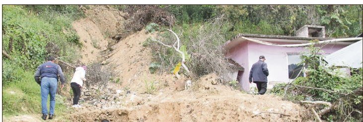
▲ Serán 24 municipios los atendidos con la relocalización de viviendas tras los daños ocasionados por las lluvias de 2025. Foto Especial
