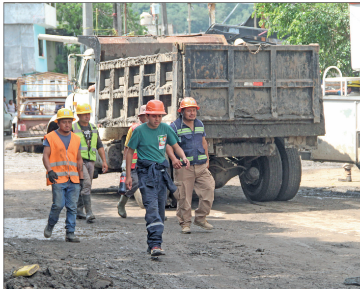
▲ La próxima semana iniciará la primera etapa de construcción de 88 viviendas en un predio de una hectárea en San Bartolo Tutotepec, en donde se brindará atención a 25 localidades. Foto Benjamín H. V.
