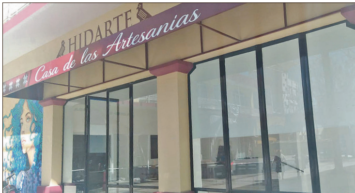
◀ La transición ha generado diversas opiniones entre la comunidad. Foto Nathali González
