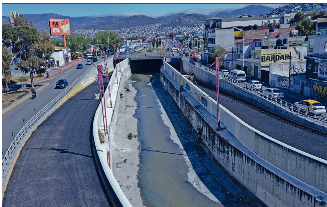
▲ Los trabajos consistieron, entre otros, en la colocación de una valla metálica, la pintura de muros en blanco y amarillo y riego de sello. Foto Benjamín H. V.
