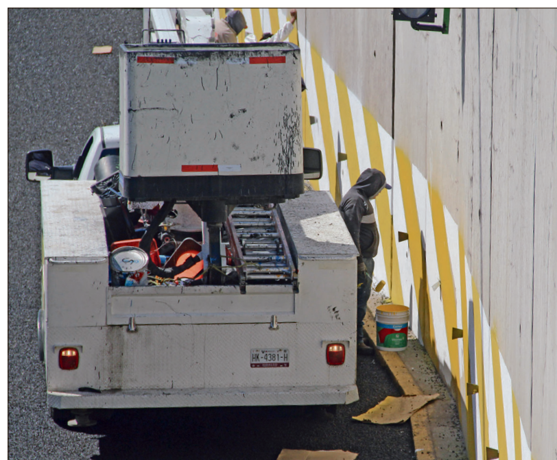
▲ Los trabajos consistieron, entre otros, en la colocación de una valla metálica, la pintura de muros en blanco y amarillo y riego de sello. Foto Benjamín H. V.
