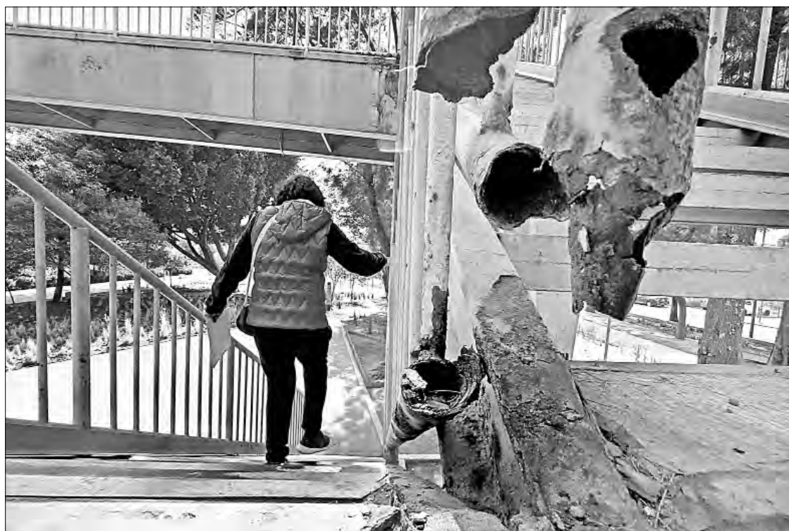
◀ Usuarios del puente sobre Periférico Oriente, entre Ermita y Eje 6, denunciaron inseguridad y mal estado debido a oxidación y desprendimiento del concreto. Foto Roberto García Ortiz
